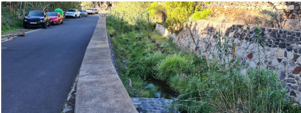
Fotografía 1. Vista de la zona superior de la actuación, obsérvese que justo donde comienza la actuación, la parte superior del barranco ya se encuentra canalizada.
