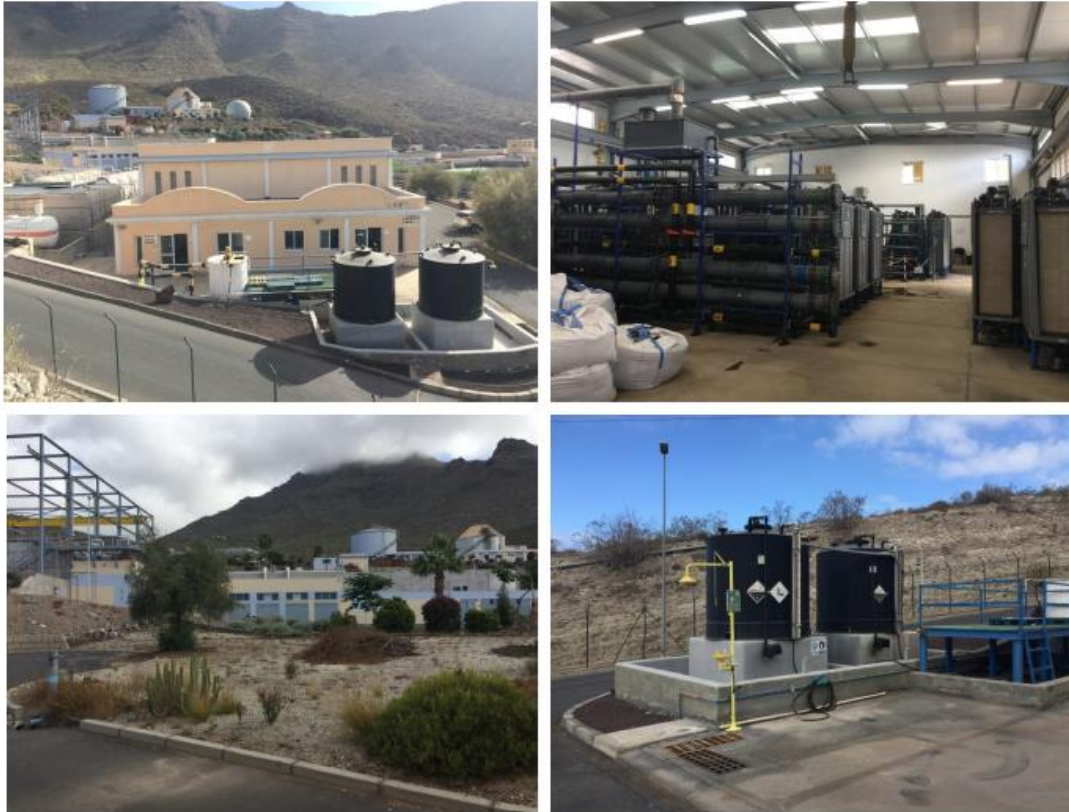
Imágenes 5, 6, 7 y 8. Vista general de la actual edificación que acoge la EDAS (arriba izqda.); detalle del interior de la nave (arriba dcha.); espacio exterior a ocupar por el nuevo depósito de alimentación (abajo izqda.); losa de descarga de reactivos (abajo dcha.).
