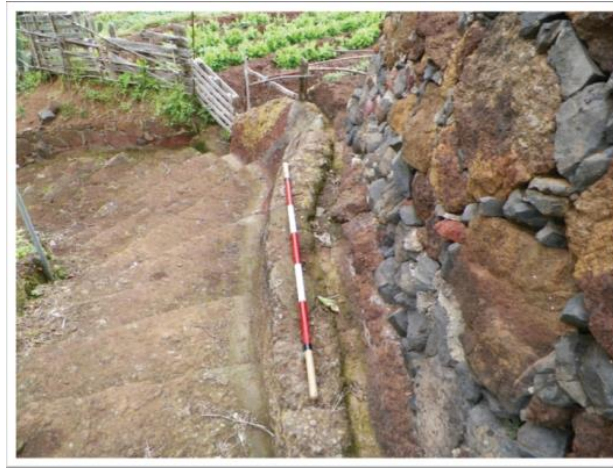
Fig. nº 14. Muro perimetral del trayecto junto al que se pueden observar los dos canales
