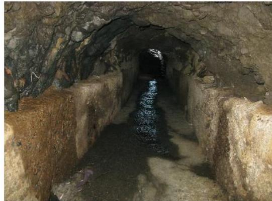
Tramo en el que se aplicará sólo impermeabilización. En la foto derecha, en primer lugar, se debe gunitar.
