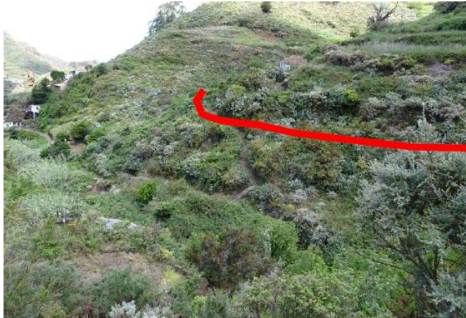
Vista general de la zona de actuación (Se marca en rojo el trazado de la pista)
